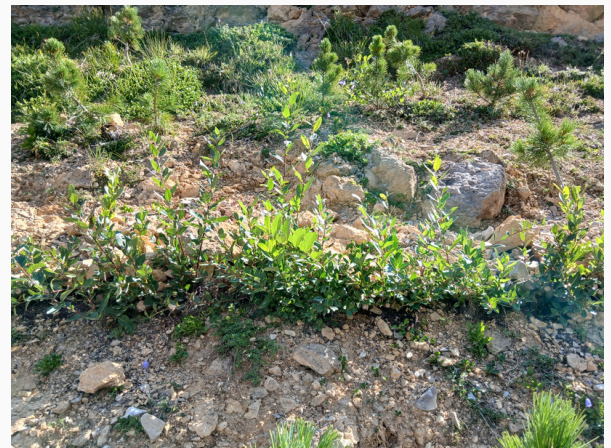
©T. Lemoine. Fascine de saule et lit de plaçon à Courchevel
