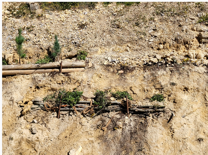
©A. Evette. Techniques de génie végétal pour stabiliser un talus érodé
